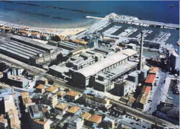
La zona dove sarà realizzato il nuovo sottovia
