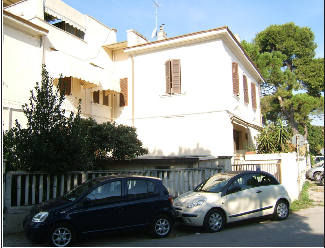
Vista da Via A. Garibaldi
