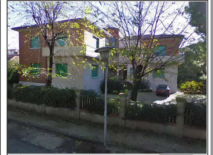
Vista da Via A. Garibaldi
