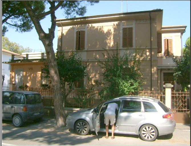
Vista da Via A. Garibaldi
