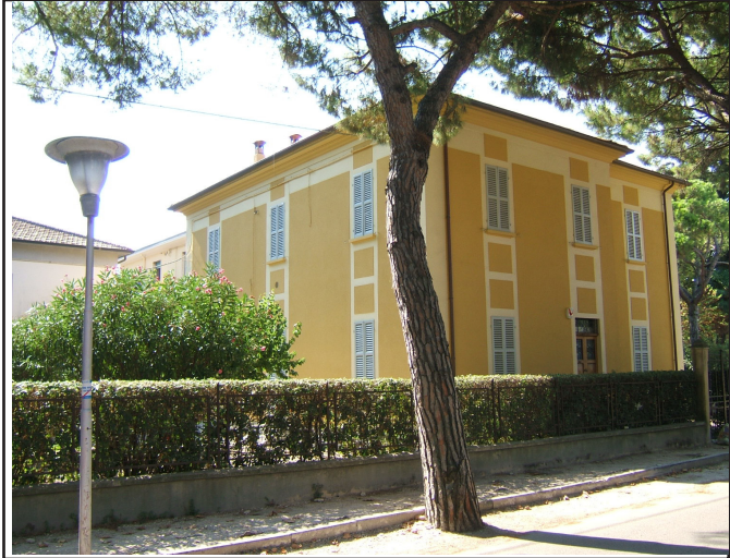
Vista da Via A. Garibaldi
