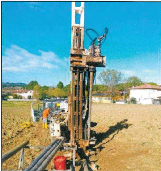
Figura 4 – Postazione sondaggio n.2 ( da report d'indagine)
