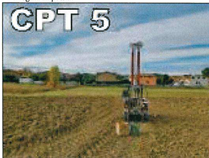
Figura 9 – Posizione dello strumento per l'esecuzione della CPT5 (da report d'indagine)
