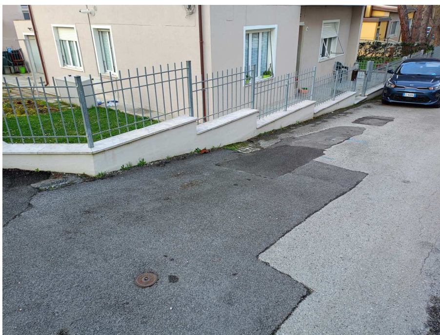
Tratto centrale con assenza di marciapiede
