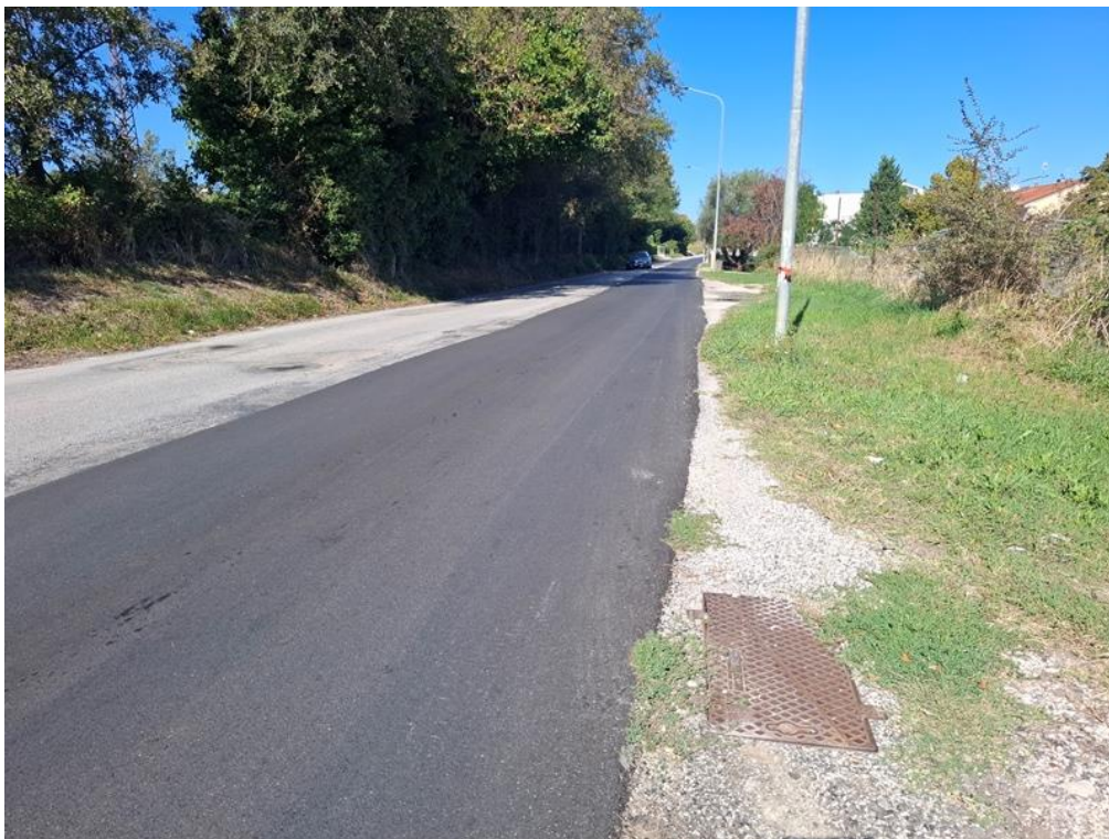
FOTO N. 13 - POZZETTO ALLACCIO FIBER COP
