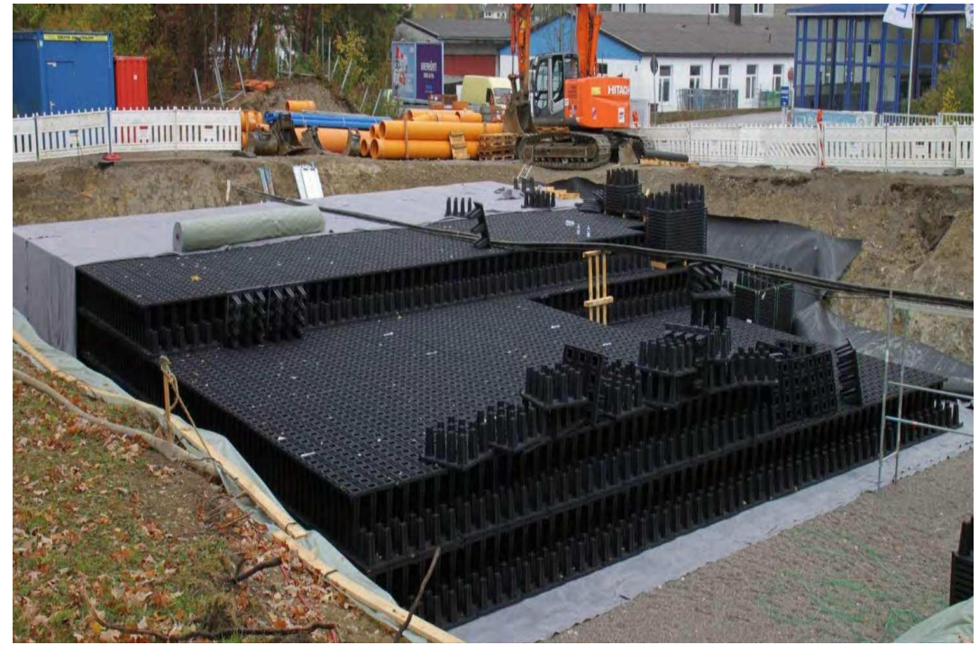
Riassetto infrastruttura esistente
