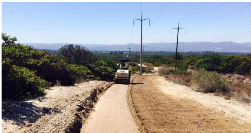
Lavorazione di un percorso in terra stabilizzata
